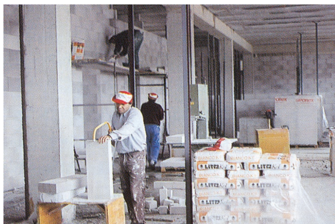
Подготовка пеноблоков
