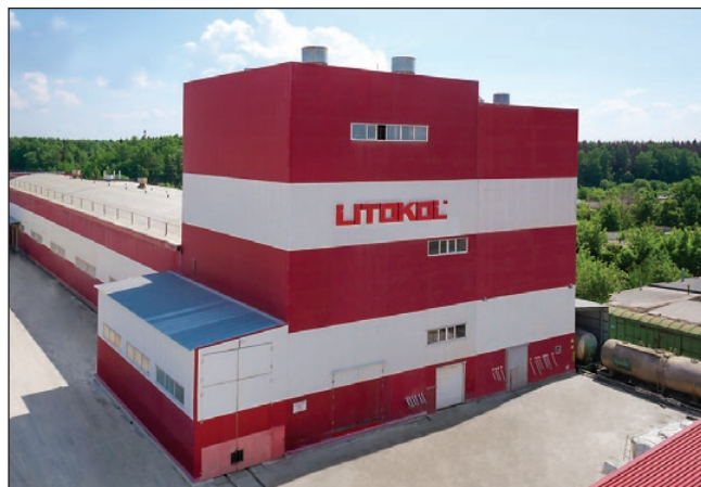
Ногинский Комбинат Строительных Смесей
