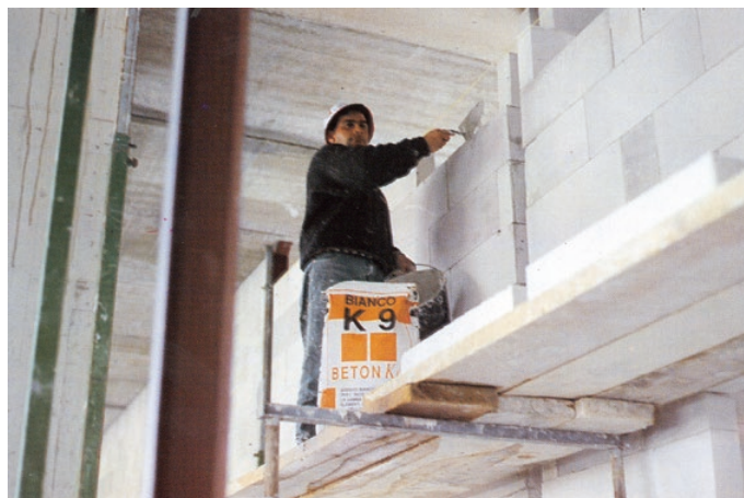
Кладка перегородок из пеноблоков
