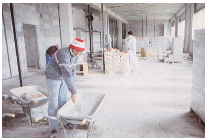
Приготовление раствора ВЕТОНКОЛ К9
